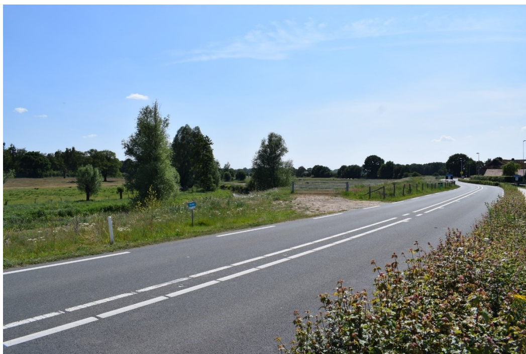
Afbeelding 37: Zichtbaar maken Dam Ven-Zelderheide (waterstaatkundig monument)
