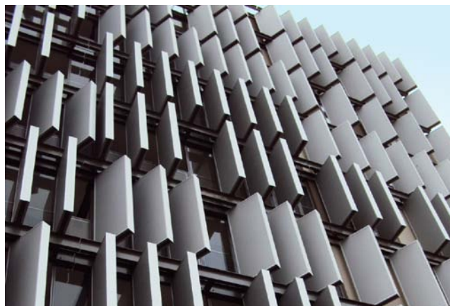
Coulissenscherm: een voorbeeld van een geluidwerende oplossing bij transformatie (Laan van Spartaan, Amsterdam)
