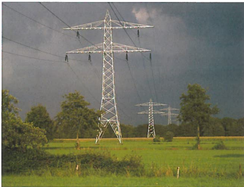
Figuur 2 Hoogspanningslijn Utrecht Lage Weide – Soest (locatie tussen mast 19 en mast 20, kijkend langs mast 20 in de richting van Soest)
