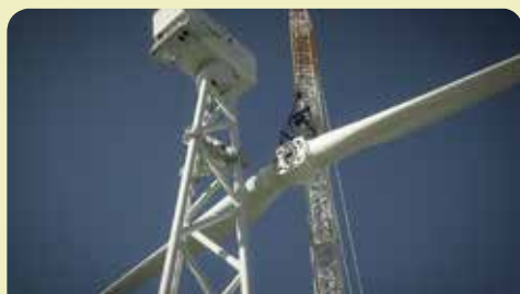
Bouw prototype Nederlandse 'offshore windturbine van de toekomst' nadert voltooiing. ⇒ 2BENERGY.COM
