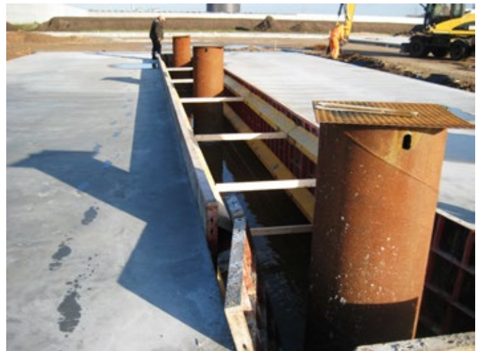
Aanleg van de drie boorgaten in Grubbenvorst (foto SodM)
