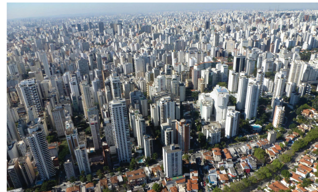
Afb. 5.4 Sao Paulo; de behoefte aan bouwmaterialen zal enorm zijn Bron: Mei architecten
