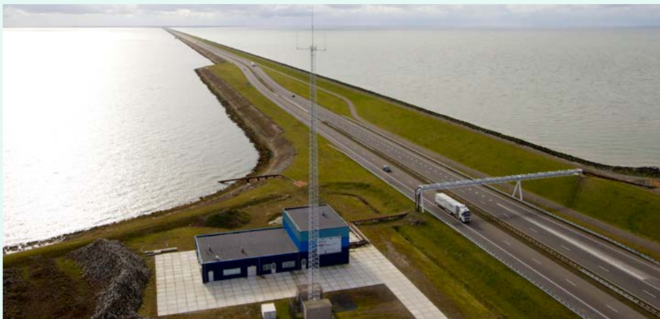
Thermische energie uit oppervlaktewater: Blue Energy op de Afsluitdijk. In deze proefinstallatie wordt energie gewonnen uit het verschil in zoutconcentratie van zout- en zoetwater.
