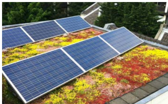
Foto 1 Adaptatie en mitigatie in één: Sedumdak met zonnepanelen. Locatie: Prinsengracht, Amsterdam. Fotografie door de Dakdokters.
