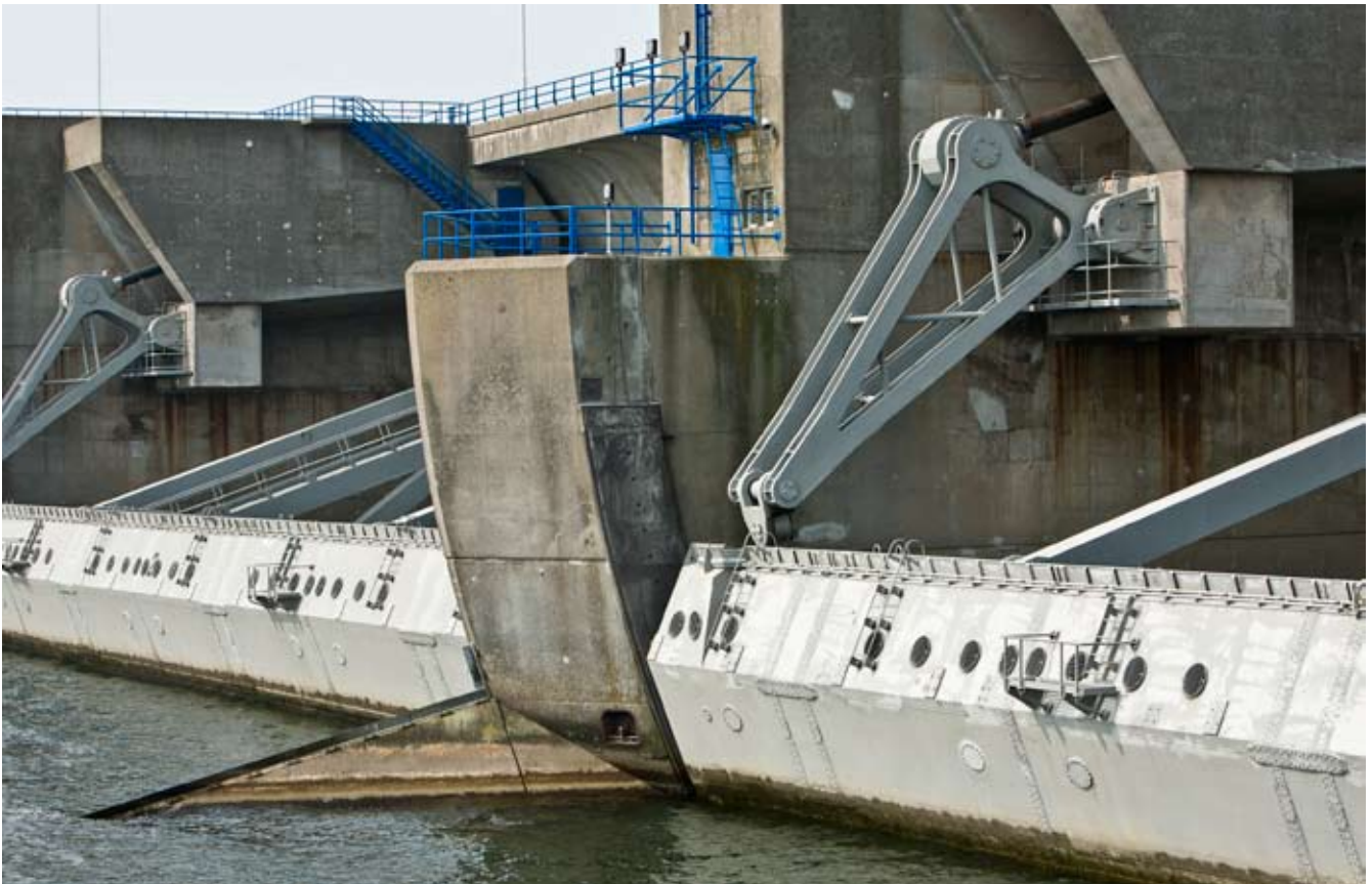
Detail van de Haringvlietsluis / Foto: inZicht
