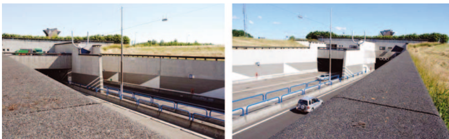
Figuur 6 Zuidelijke tunnelmond Wijkertunnel Rijksweg A9
