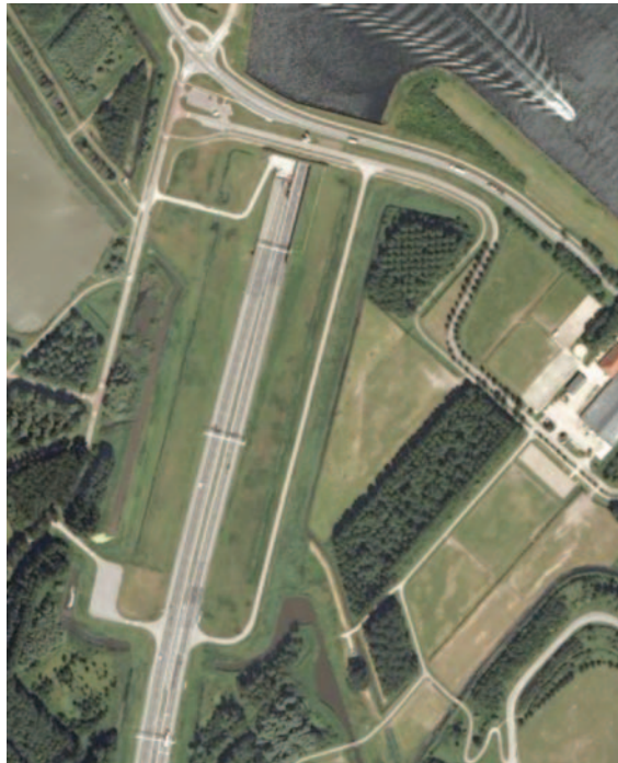
Figuur 7 Meetlocatie tunnelportaal zuidzijde Wijkertunnel Rijksweg A9
