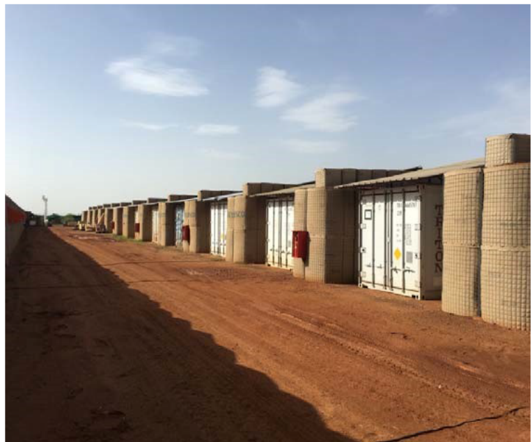
Bunkers met zonedak.
