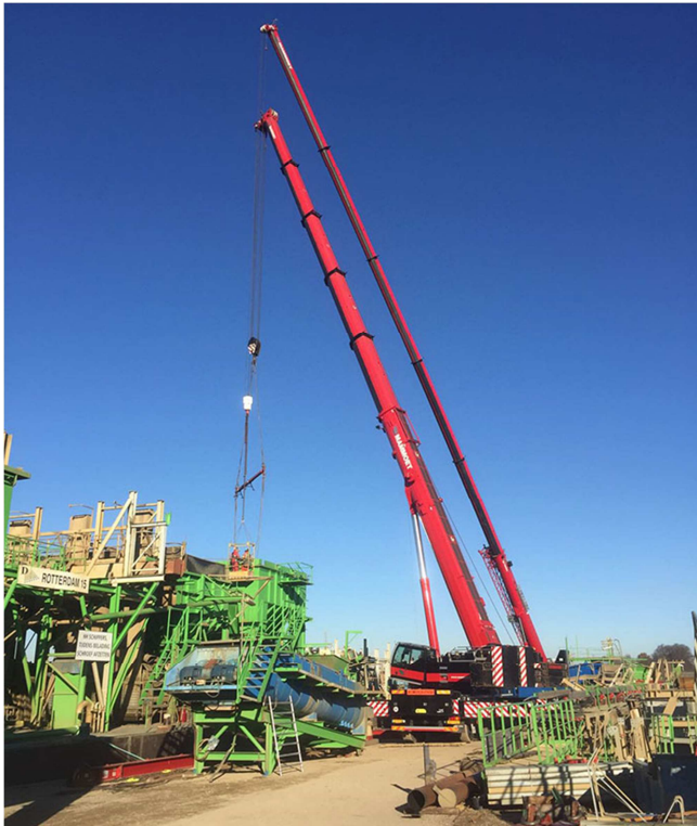
Demontage van "de Rotterdam" te Itteren
