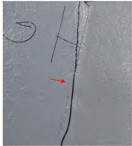
Figuur D 11 Foto's van scheuren met sterke aanwijzing van conservering over de scheur (bovenste foto uit [3], overige foto's 9117, 9118 en 9119 uit [4]).
