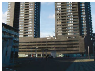
De openbare ruimte rondom de Hoge Heren is een winderig boomloos plein.
