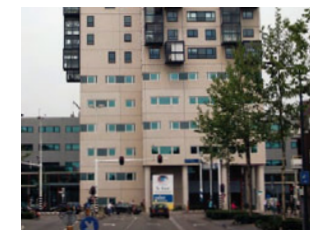
De toren loopt door tot op maaiveld. Detaillering en materiaalgebruik op de onderste verdiepingen verdienen meer aandacht.
