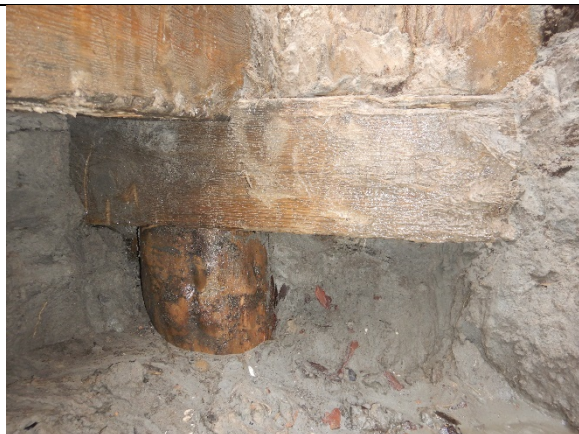
Figuur 9.15: Kesp 3 en paal 3
