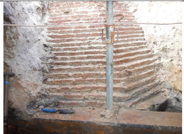
Figuur 9.4: Funderingsmetselwerk
