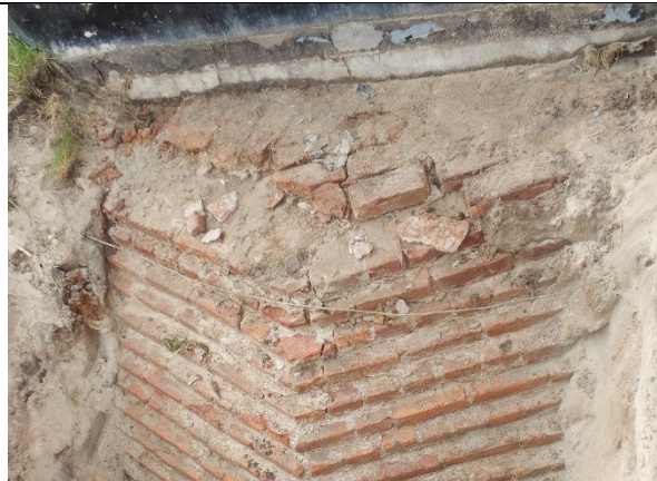
Figuur 9.3: Bovenzijde funderingsmetselwerk
