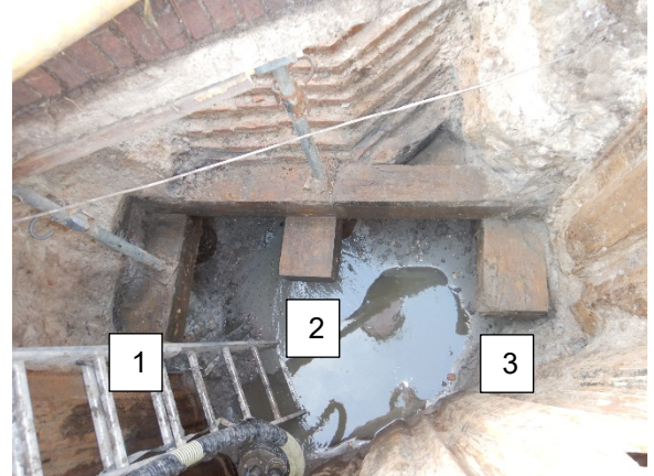
Figuur 9.2: Overzichtsfoto inspectieput
