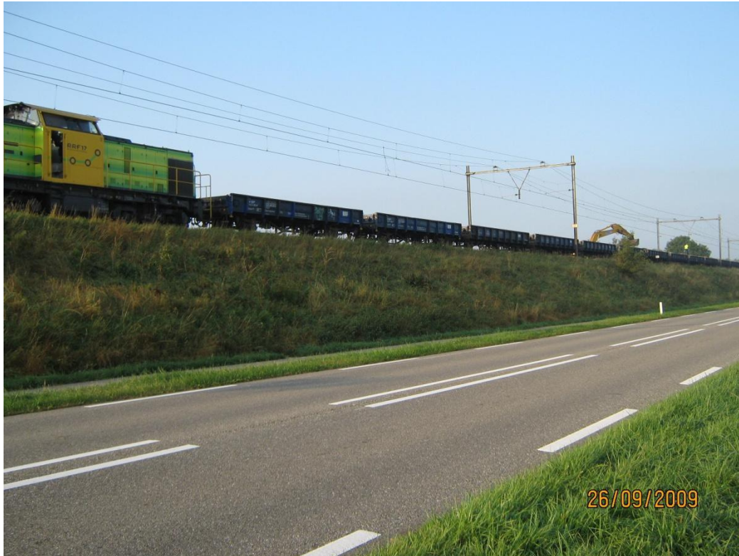
Foto 2.2: Graafmachine graaft oude ballast af bij Rilland Bath
