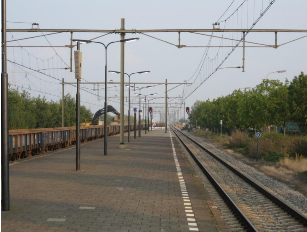
Foto 1.2: Graafmachine op het station Kruiningen-Yrseke
