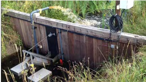
Figuur 3: In het kennisprogramma Lumbricus ontwikkelen overheden en kennisinstellingen, maatregelen waarmee zij méér en beter water vasthouden in het watersysteem, zoals de Slimme Stuw. Bron: Programma Lumbricus
