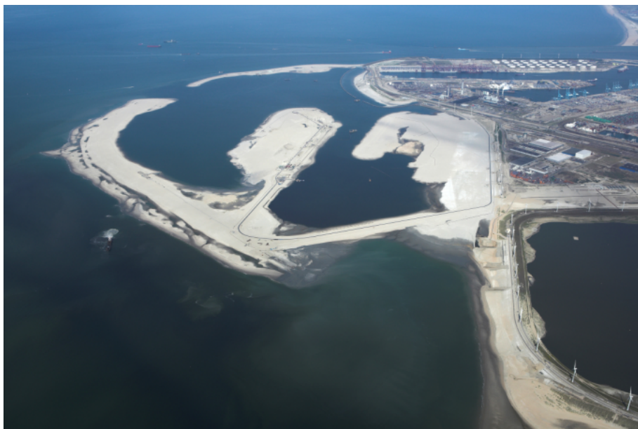
Figuur 3: Luchtfoto Maasvlakte 2 in aanleg – opgenomen juli 2010
