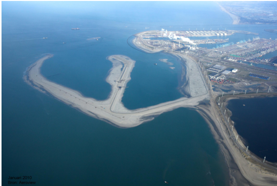
Figuur 2: Luchtfoto Maasvlakte 2 in aanleg - opgenomen januari 2010
