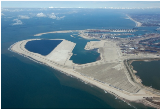
Foto: Maasvlakte 2 in aanleg (juni 2012)
