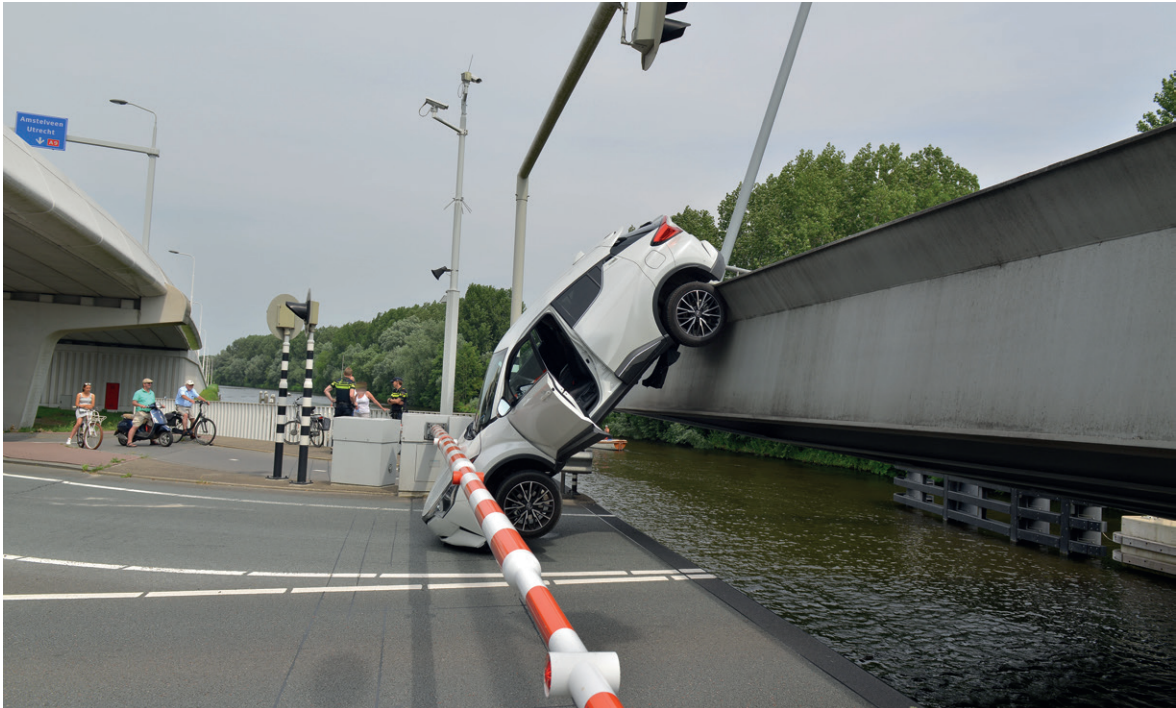
Figuur 12: De Bosrandbrug. (Bron: HFV / Eric van Lieshout)
