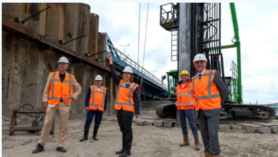
Start werkzaamheden aan de Suurhoffbrug (BRON: PAUL VAN BAARDWIJK)
