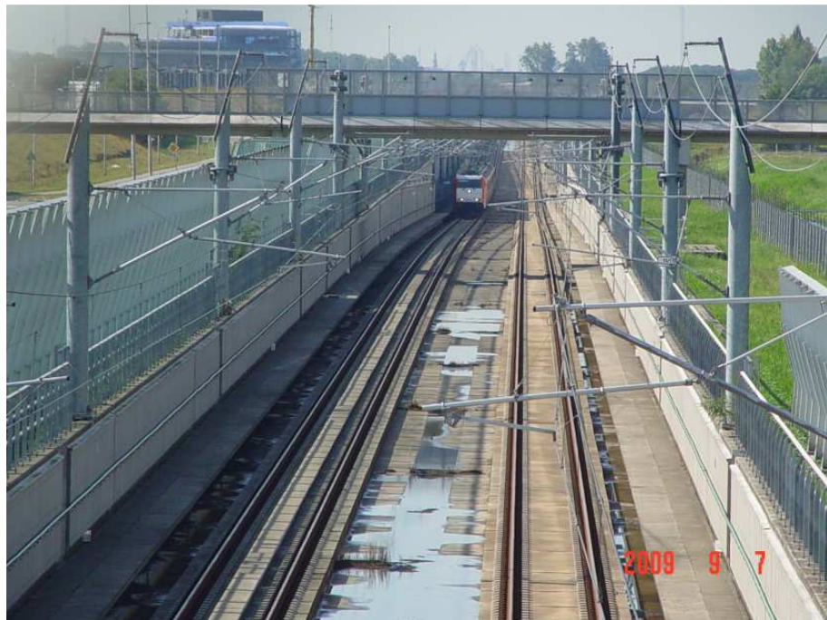
Figuur 4 Meetdoorsnede D2 bij km 110.510 (voorgrond, km bord 110.5 rechts) en meetdoorsnede D3 bij km 110.190 (verderop). Aanzicht richting Rotterdam vanaf het Offenbachviaduct. Het oostspoor links heeft gedeeltelijk een betonnen ontsporingsbalk.
