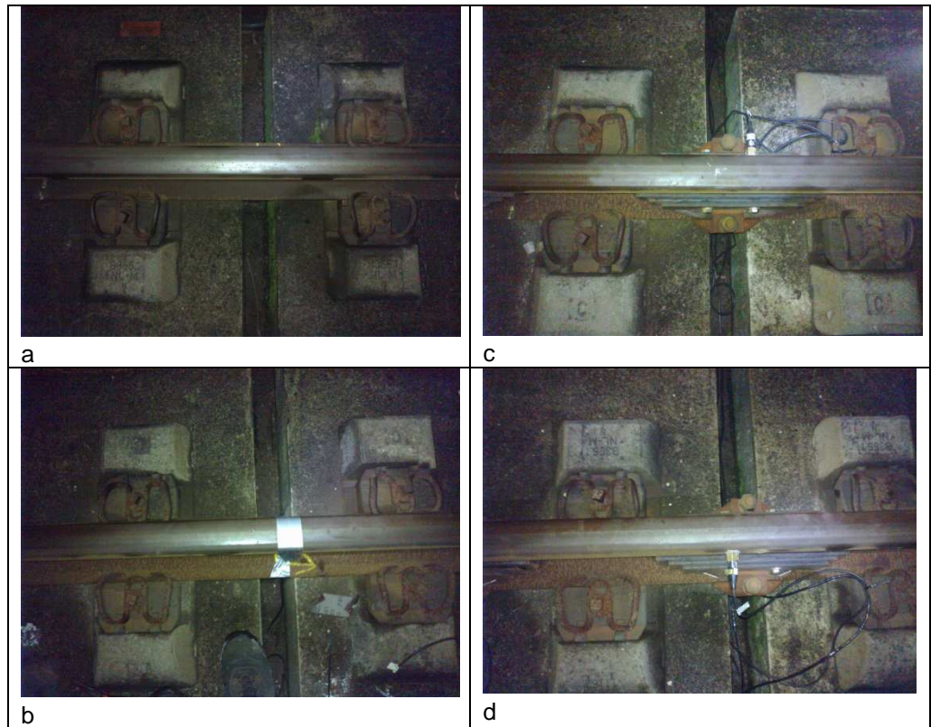
Figuur 100 Railloopvlak bij de nameting op meetdoorsnede 2, a) oostspoor buitenrail, b) oostspoor binnenrail, c) westspoor binnenrail, d) westspoor buitenrail.
