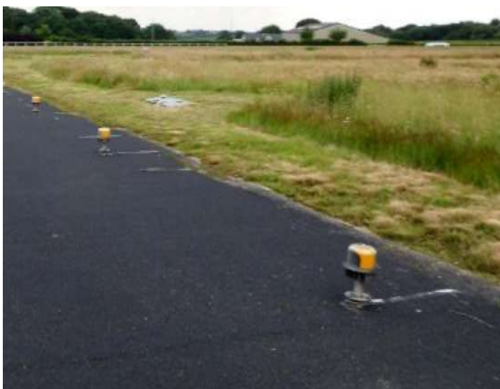
Figuur 12 Baaneinde verlichting 03
