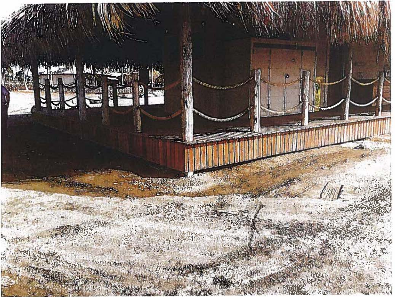
Foto toont duikschool gebouw van dichterbij aan. Duidelijk te zien dat de container is bekleed met houten planken.
