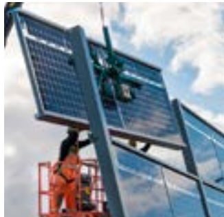
Op onbenutte terreinen: Solar Highway is het eerste dubbelzijdige stroom-opwekkende geluidsscherm van Nederland.
