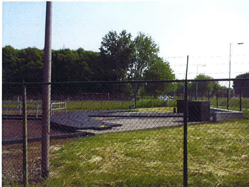
Figuur 2; Tunnelleinde leidingentunnel Groene Kruisweg noordzijde.
