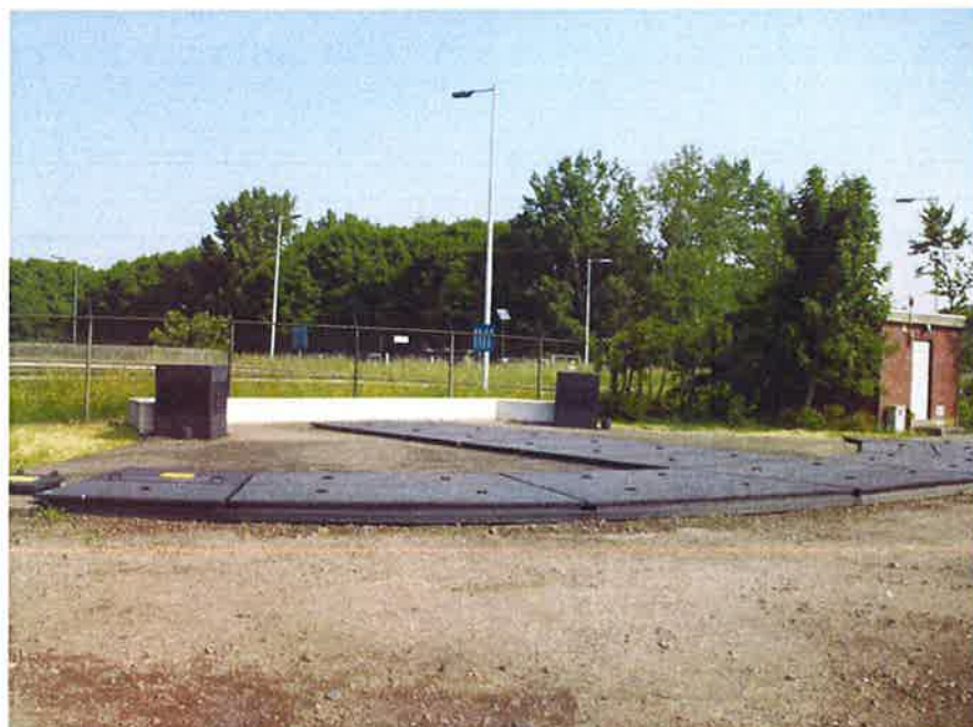
Figuur 3; Tunnelleinde leidingentunnel Groene Kruisweg zuidzijde.
