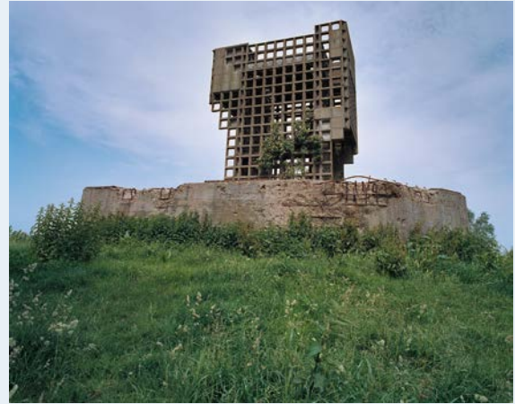
Luchtwachtoren Strijensas (5K3) uit 1953 (gemeentelijk monument) gebouwd bovenop een Nederlandse VIS-kazemat (rijksmonument) uit 1937, in 2012 gerestaureerd. Foto: Commons Wikimedia.
