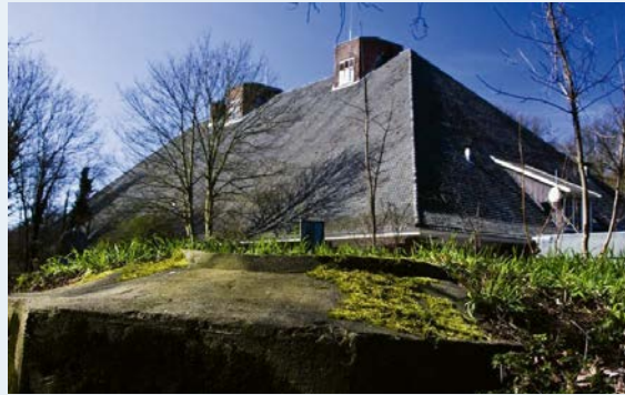
Als boerderij gecamoufleerde bunker van Seyss-Inquart in Wassenaar uit 1943, deel van Stützpunktgruppe Clingendael (Atlantikwall) met eigen tankgrachten en bunkers. Foto: Rijksvastgoedbedrijf.
