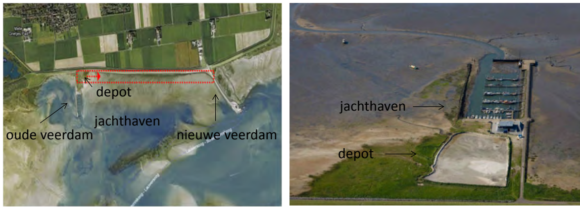
Figuur 12 Links: Luchtfoto van het casestudiegebied Waddenzee, met links de oude veerdam, jachthaven en depot, rechts de nieuwe veerdam en daartussen de locatie voor baggerstort t.b.v. de beoogde vooroever (aangegeven met rode stippellijn); aangepast uit de Passende Beoordeling (ARCADIS 2009). Rechts: De jachthaven van Schiermonnikoog, met op de voorgrond het baggerdepot (Bron: http://www.schierweb.nl/2010.htm ).
