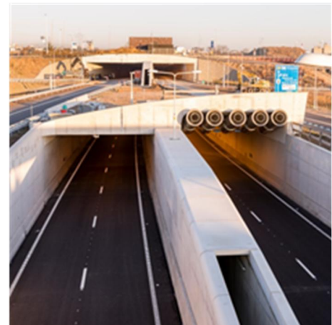
Figuur 9.1 Vier tunnelmonden
