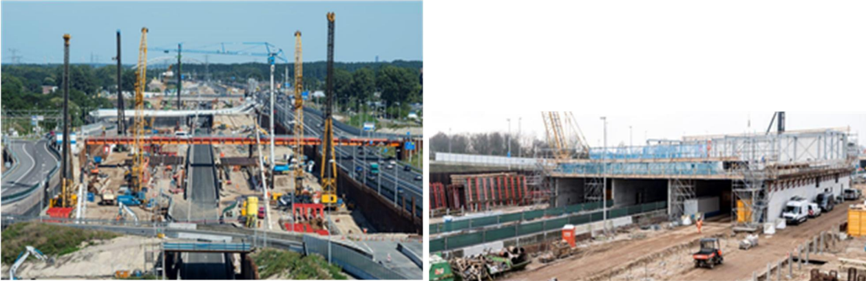
Figuur 11.3 Bouw tunnel A9 Gaasperdammerweg
