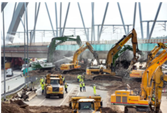
Figuur 11.2 sloop oude spoorbrug (links) en inrijden nieuwe spoorbrug (rechts)
