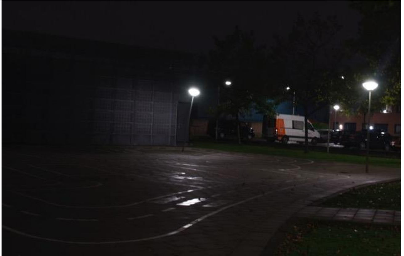
Figuur – de verlichtingspaal in het midden van de foto staat duidelijk krom. Als hier lange tijd niets aan gedaan wordt, communiceert dit naar mensen die ruimte vaak gebruiken dat er geen zorg gedragen wordt voor de openbare ruimte.
