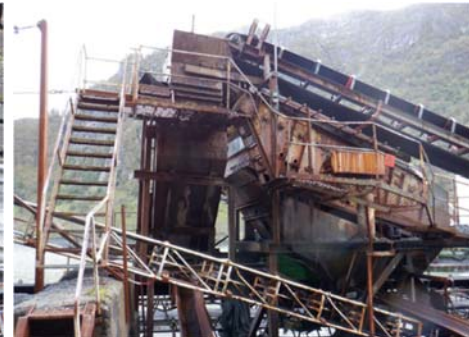
Eikefet: 2 wassers, nadere inspectie niet mogelijk
