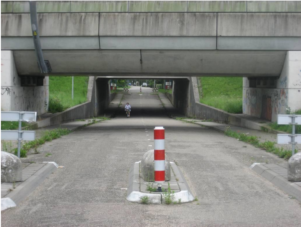
Figuur 19 Passage Bredestraat onder halfverhoogde Betuweroute en A15 door
