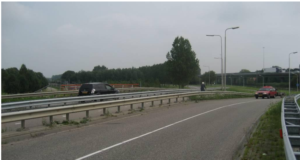
Figuur 9 Betuweroute in half verdiepte open bakken verhoogde A15 op de achtergrond. De zwarte auto rijdt op de N216, de rode op de aansluiting van de Schelluinesebrug
