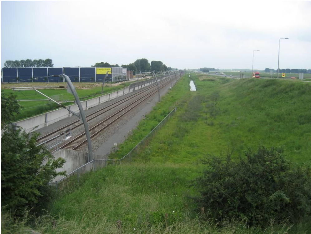
Figuur 14 Betuweroute gezien van de N848 met rechts afrit 29 van de A15
