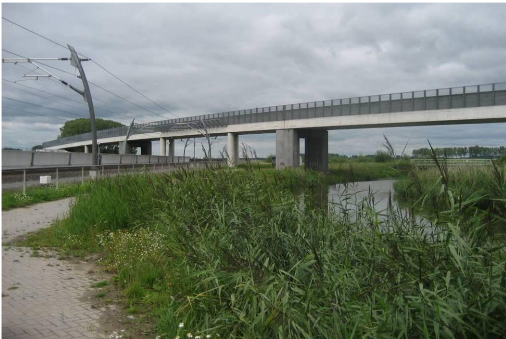
Figuur 17 Brug Betuwelijn over Linge, Betuweroute en A15 (niet zichtbaar)
