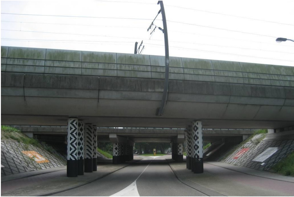
Figuur 11 Grote Haarsekade onder Betuweroute en A15 door
