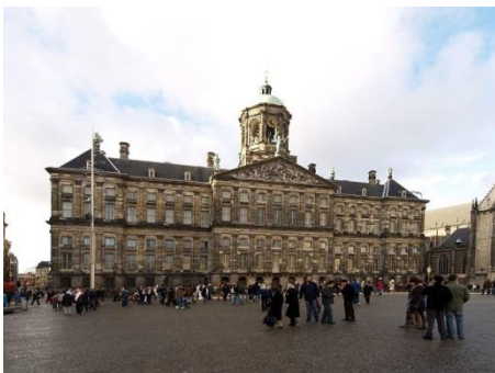
Paleis op de Dam, Amsterdam
