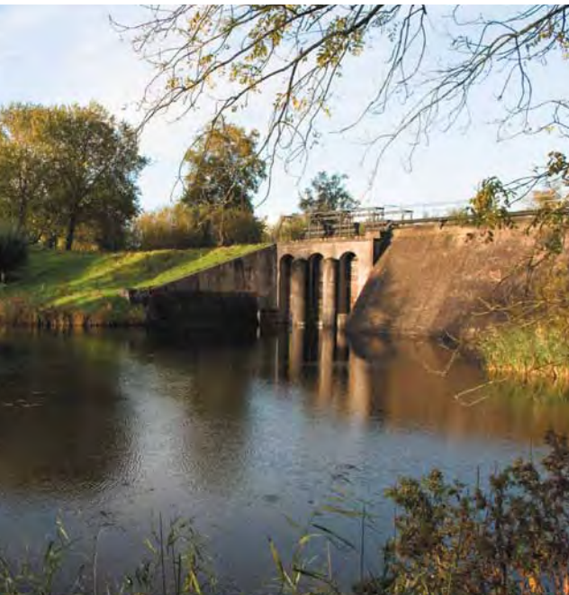
Aanzicht fort langs ingang
