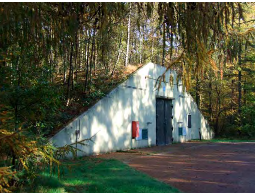
Grondgedekte bunker op het terrein
