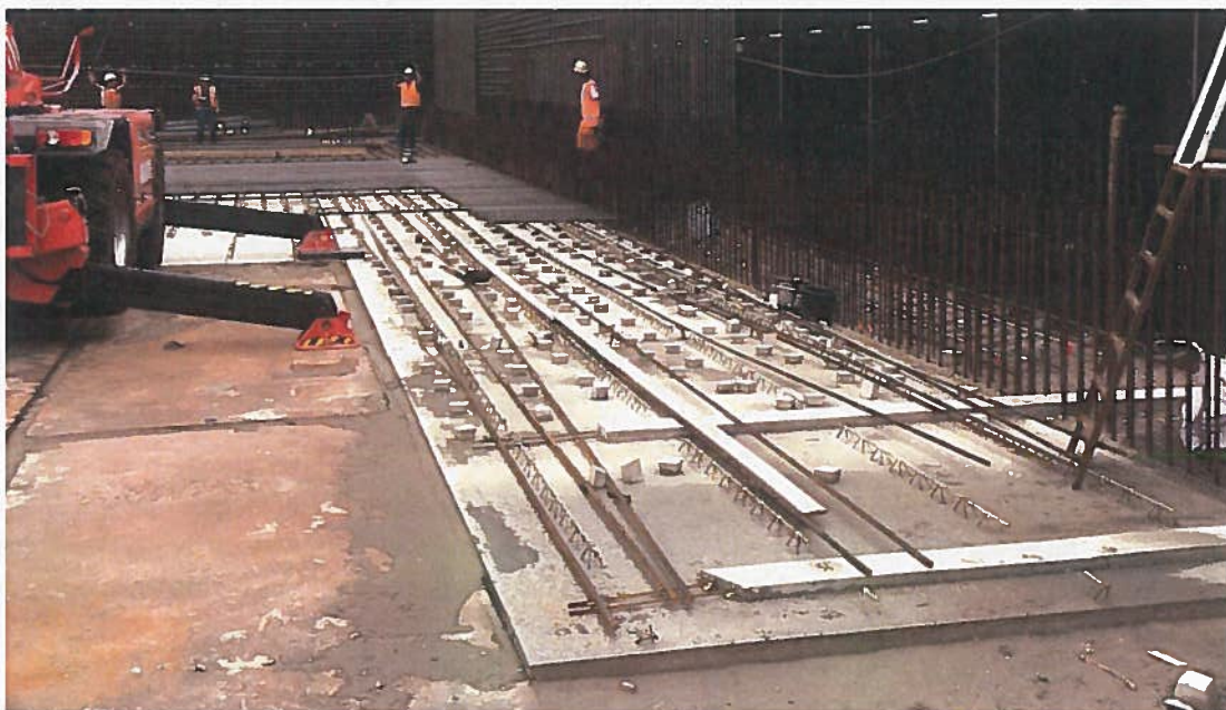
Figuur 22 Foto genomen ten tijde van de start van het maken van de vloer, waarbij de toegepaste breedplaten zijn te zien (Bron: OpenIJ).
