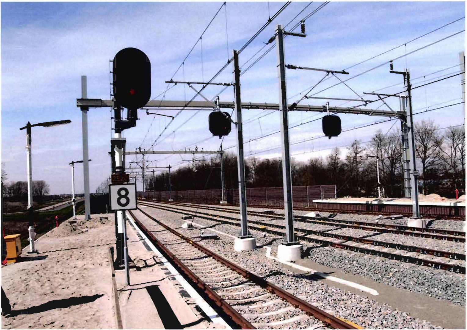
De Hanzelijn is uitgerust met ERTMS en het huidige veiligheidssysteem (dual signalling).
