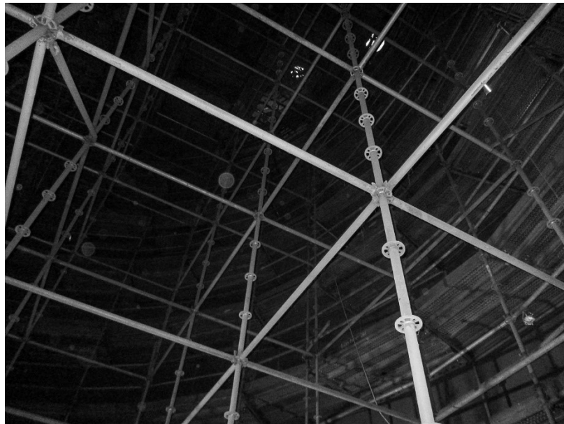
Meetlocatie 1C: Overzicht van steiger aan binnenkant van de tank
