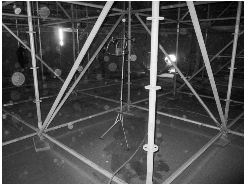
Meetlocatie 1C: Positie stationair meetpunt tijdens verplaatsen/inspectie
