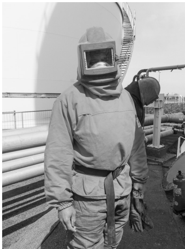
Meetlocatie 1C: Beschermende kleding, inclusief straalkap, zoals gedragen door straler tijdens straalwerkzaamheden
