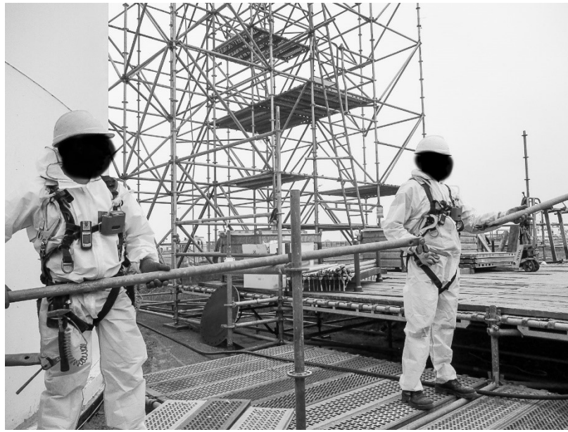
Meetlocatie 1C: Annemen en opstapelen steiger materiaal
