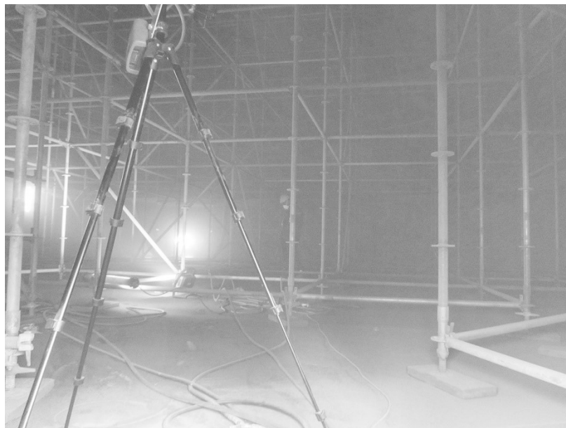
Meetlocatie 1C: Positie stationair meetpunt tijdens verplaatsen/inspectie
