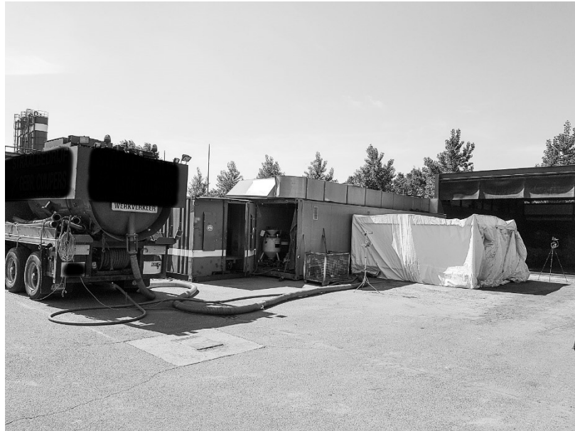
Meetlocatie 2B: Overzichtsfoto straal tent, inclusief posities stationaire meetpunten (<1 meter en >5 meter van opening) en positie straal/zuig unit (vrachtauto)
