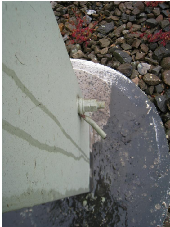
Figuur 6. Foto van ontbrekende paalspoorstaafverbinding te Goes, Zeeland.
