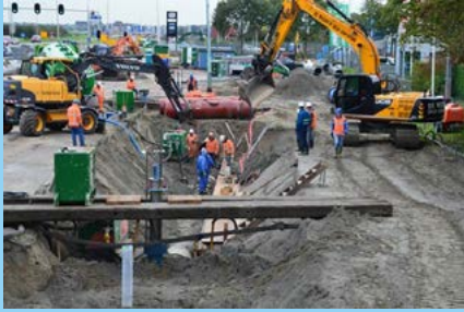
Omschakelen van oude naar nieuwe leiding
