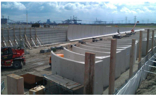
Figuur 4: Foto Knooppunt B in uitvoering (juli 2011)
