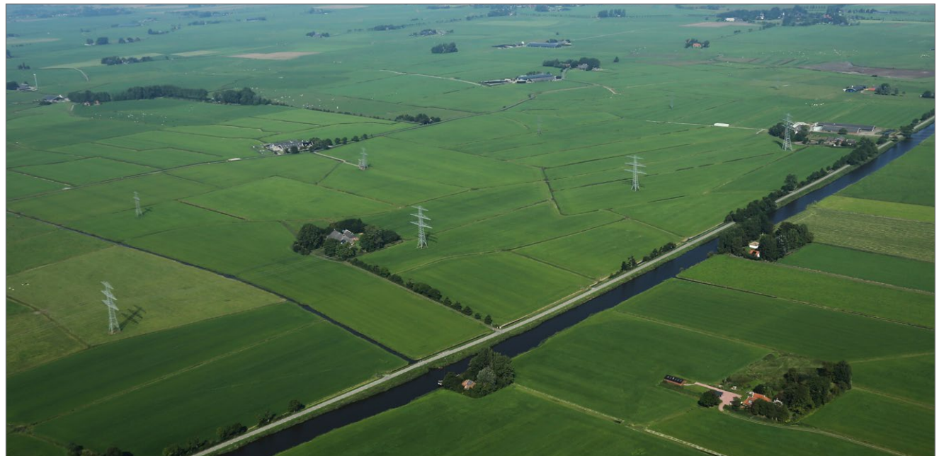
fig. 12 Luchtfoto Middag Humsterland nabij Brillerij. Boven met huidige 220kV lijn met vakwerkmasten. Onder met nieuwe 380kV verbinding met Wintrackmasten. De bestaande 110kV verbinding is afgebroken.
