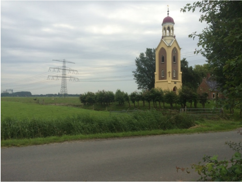
Foto van de monumentale kerktoren met op de achtergrond de bestaande 220 kV hoogspanningsverbinding.
