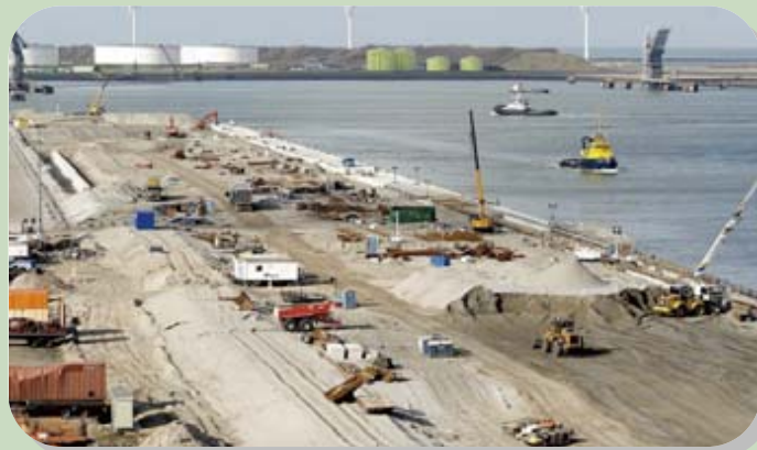
Uitvoering intensivering en aanleg DBFT-terminal Maasvlakte
