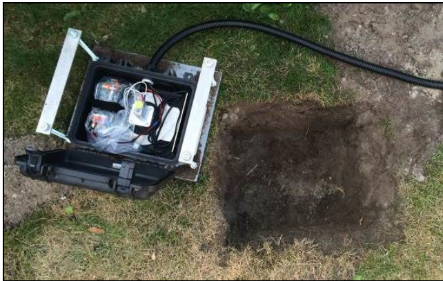
Figuur 2.2: Aanbrengen trillingsmeter in de bodem
