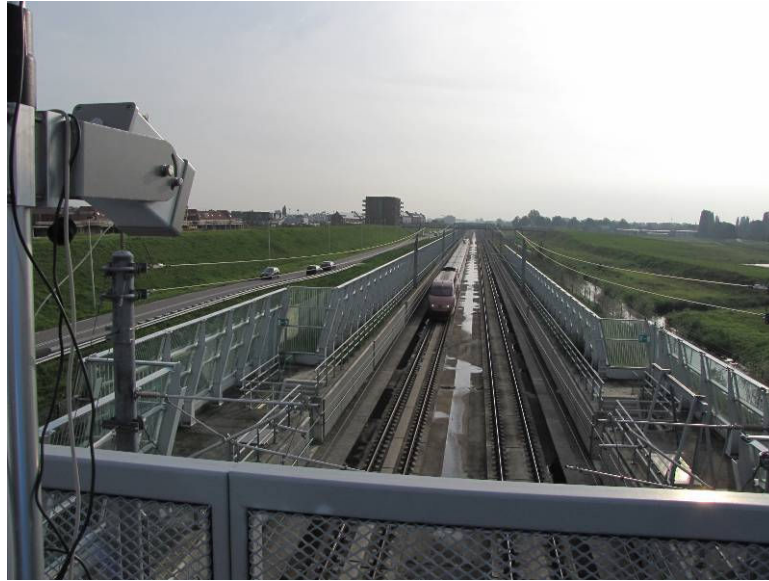
Figuur 4: De tunnelbak in Lansingerland gezien vanaf het viaduct Offenbachlaan tussen het Bachplein en de Witteveenstraat, kijkend richting Rotterdam.
