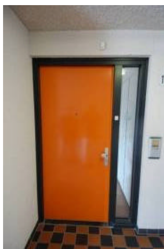
Op afstand bedienbare toegangsdeur tot woning
