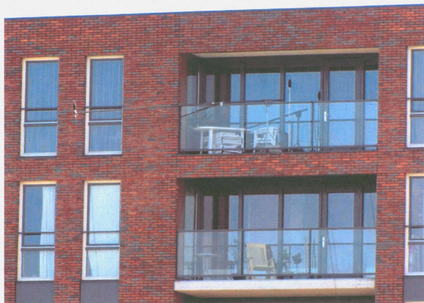
Figuur 2: Overzicht van de meetlocatie Witteveenstraat, aan de oostkant van het spoor. Microfoons zijn gepositioneerd op 2 meter vóór de gevel van de woning en op het balkon.
