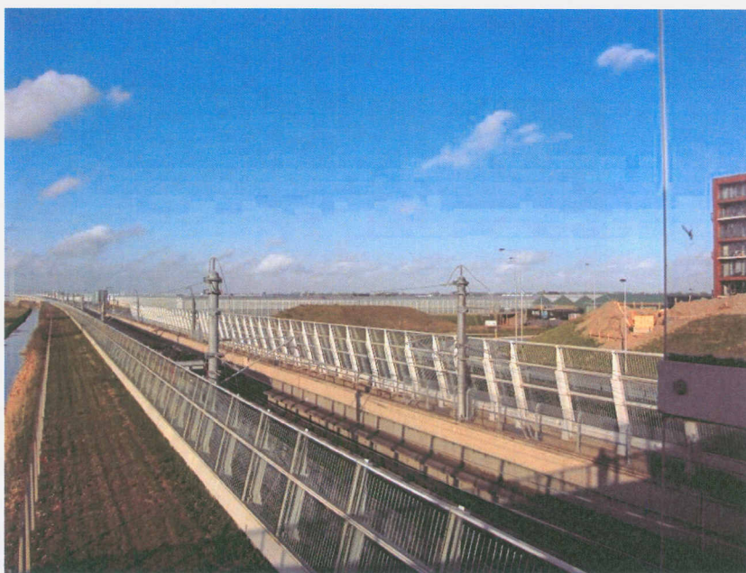
Figuur 3: De tunnelbak in Lansingerland gezien vanaf het viaduct Offenbachlaan tussen het Bachplein en de Witteveenstraat, kijkend richting Rotterdam (boven) en kijkend richting Amsterdam (onder).
