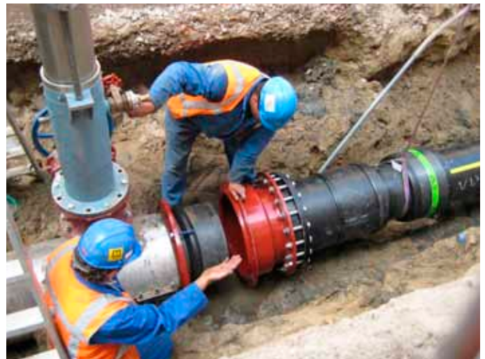
Vervangen grijs gietijzer in Amsterdam (foto SodM)
