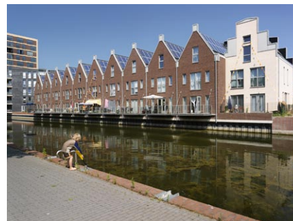
Nieuwbouw en Herstructurering
