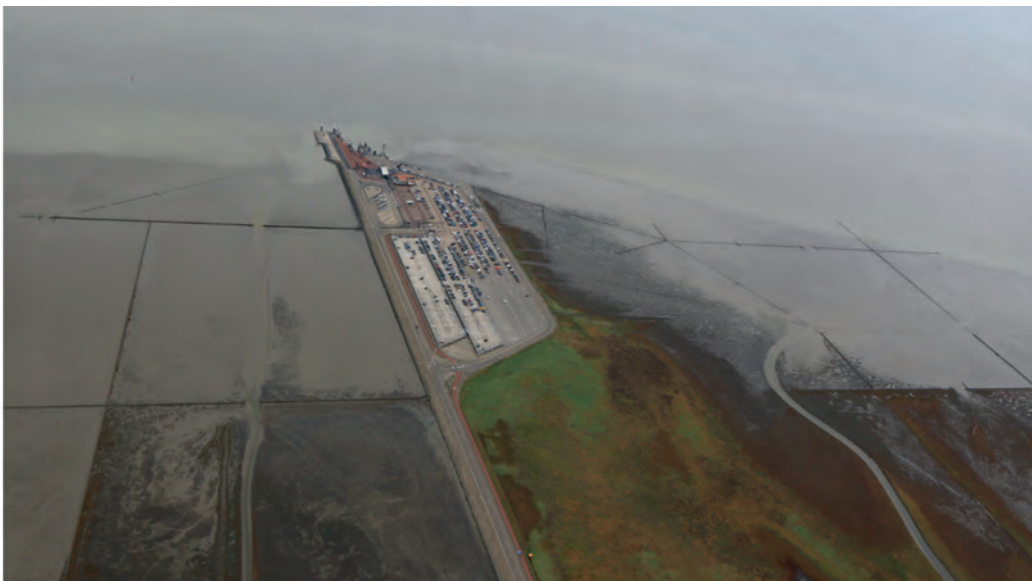
Figuur 3 De veerdam heeft samen met de tevens goed zichtbare landaanwinningswerken gezorgd voor een sterke aangroei van de platen en kwelders aan weerszijde van de dam. De huidige dam met parkeervoorzieningen heeft daarmee een sterke invloed op de morfologische ontwikkeling rondom de vaargeul (FOTO: Luchtsurveillance Rijkswaterstaat).
