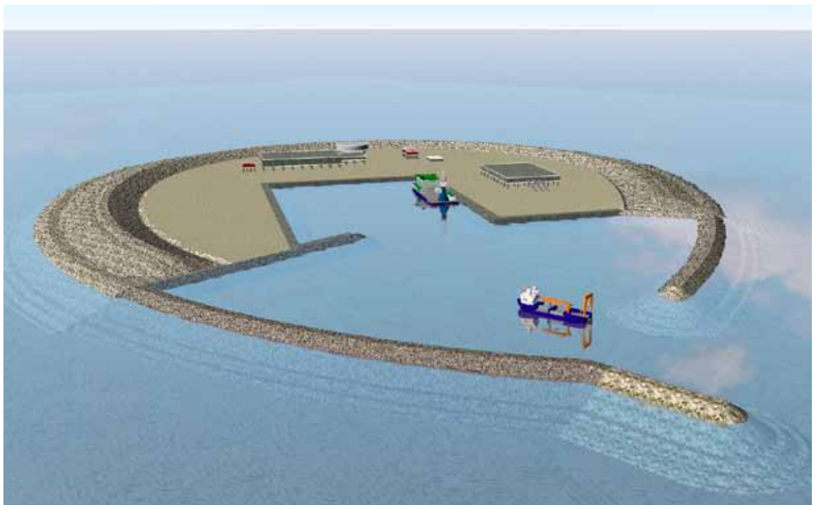
Impressie service-eiland voor onderhoud/aanleg offshore windparken, beperkt tevens het aantal kruisende bewegingen, bron: Van Oord
